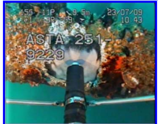
Non Destructive Test - FMD
